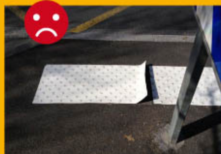
Dalles plastique : risque de décollement rapide, de chute ou de non détection danger
