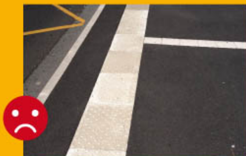
Dalles en béton lisse : noircissement rapide, apparition de variations de teintes, risque de glissance non conforme.
