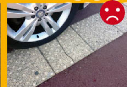
Dalles en béton ou béton de résine de trop faible épaisseur: risque de casse lors de franchissements occasionnels de bus, véhicules de secours ou de service.
