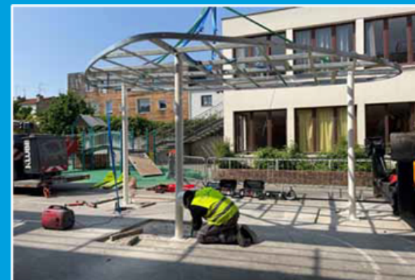
Installation et suivi
