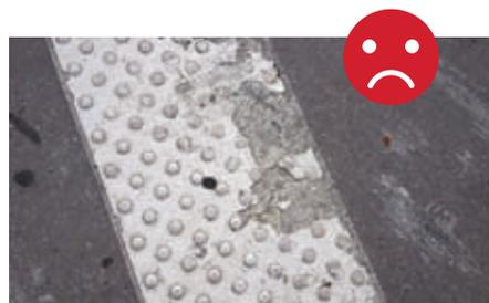
Dalles résine risque d'usure rapide, de chute ou de non détection danger
