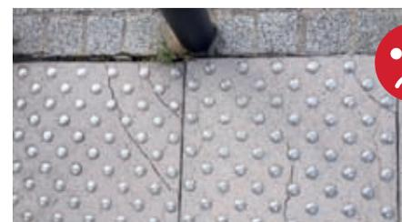
Dalles «SMAC» en bitume et inox: apparition de fissures lors de variations de température.
