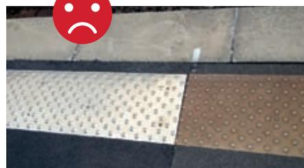
Plaques vissées en inox : apparition rapide de corrosion.
