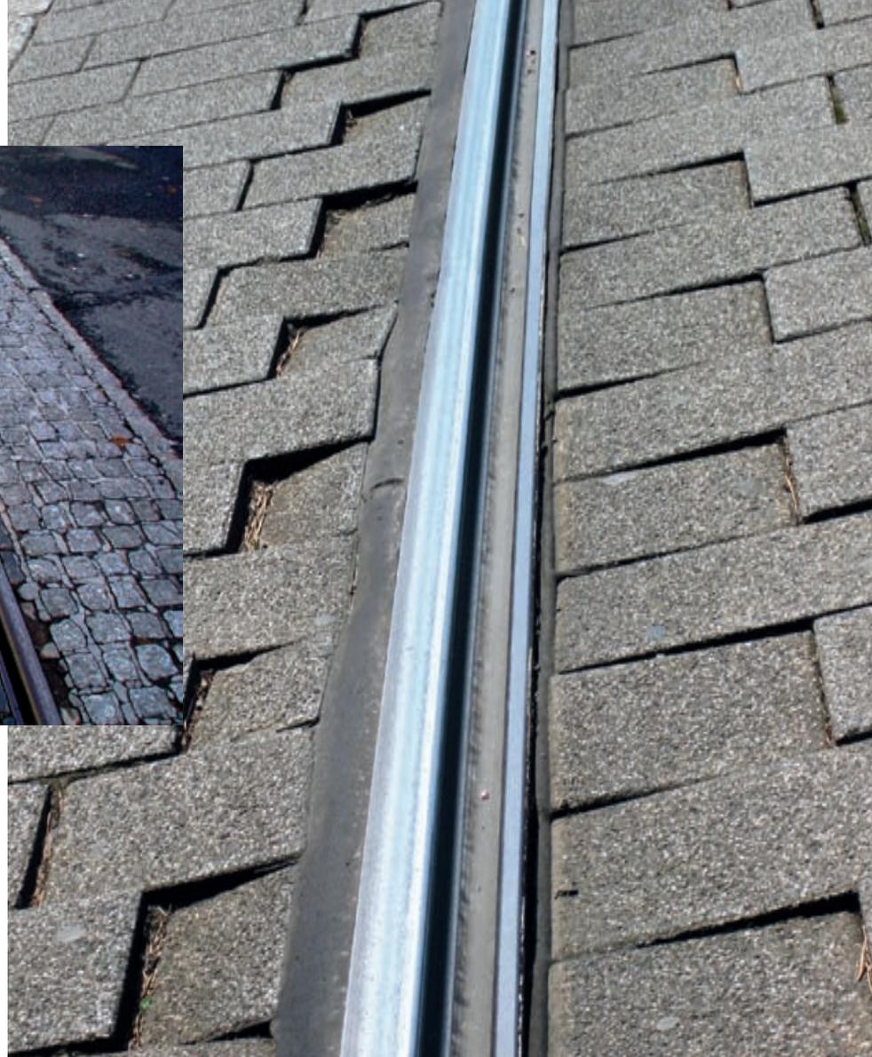
Pavés classiques en béton désolidarisés par le passage de véhicules
