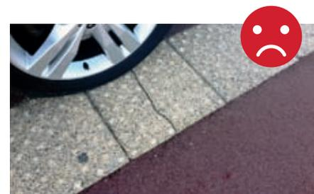
Dalles en béton ou béton de résine de trop faible épaisseur: risque de casse lors de franchissements occasionnels de bus, véhicules de secours ou de service.
